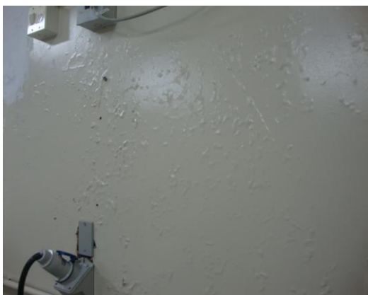
Fig:24. Umidade na parede e reforma inacabada
