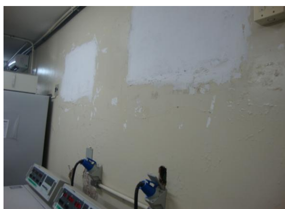
Fig:24. Umidade na parede e reforma inacabada
